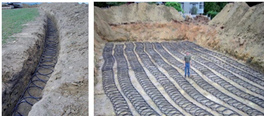
Slika 17 Posebne izvedbe horizontalno položenih izmjenjivača (kolektorska polja)
