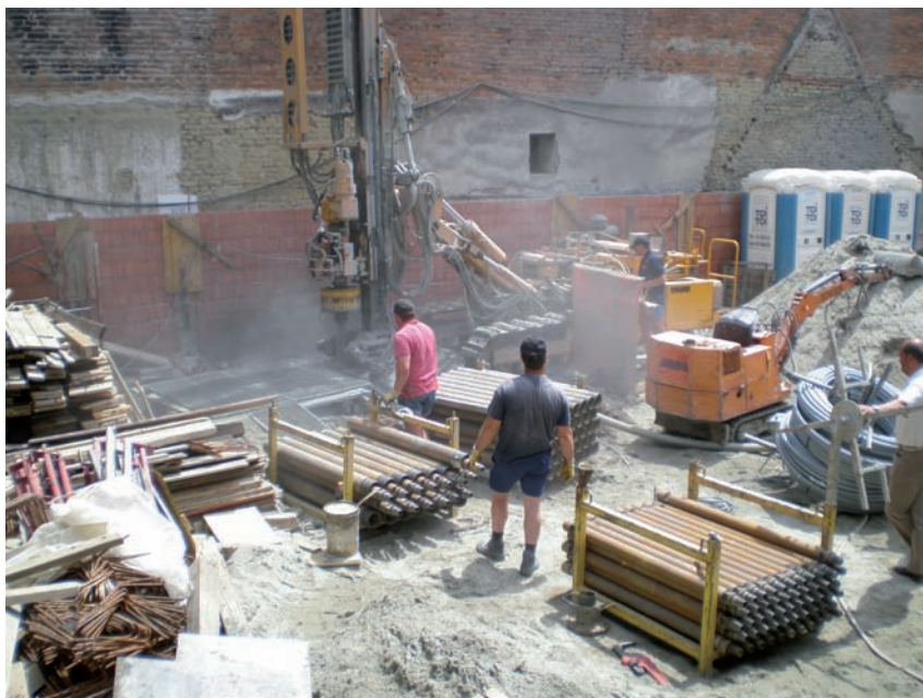
Slika 19. Bušenje vertikalnih bušotina za postavljanje U-cijevi izmjenjivača (2008. godine)
