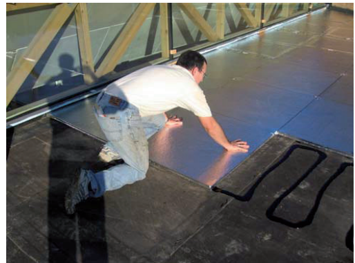
Verlegen von VIP's am Flachdach
