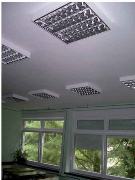
Slika 1: Prva Osnovna škola Ogulin – Rekonstruirana rasvjeta i sanirana vanjska stolarija
