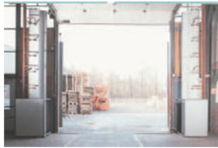
Ilustracija 4. Vertikalna ugradnja zračnih zavjesa
