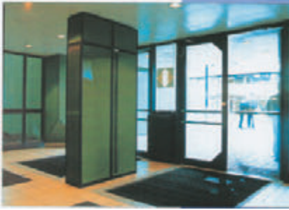
Ilustracija 4. Vertikalna ugradnja zračnih zavjesa
