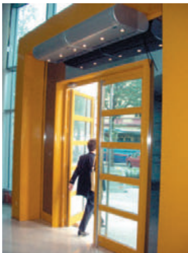
Ilustracija 3. Horizontalna ugradnja zračne zavjese
